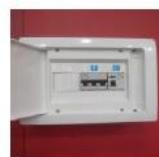
**5- O CD deverá ser em PVC com fiação seccional, disjuntores e DR compatíveis com as cargas dos estande.**
